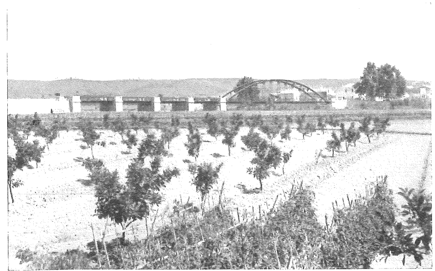
Foro 24 Puente sobre el Júcar en Gabardá.
